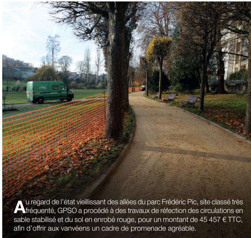
À la vue de l'état vieillissant des allées du parc Frédéric Pic, site classé très fréquenté, GPSO a procédé à des travaux de réfection des circulations en sable stabilisé et du sol en enrobé rouge, pour un montant de 45 457 € TTC, afin d'offrir aux vanvéens un cadre de promenade agréable.
