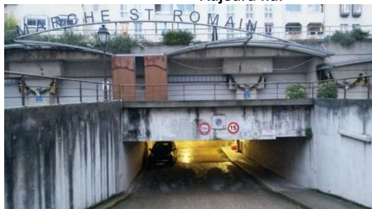
Actuelle rampe d'accès au parking Saint-Romain (source : GPSO)
