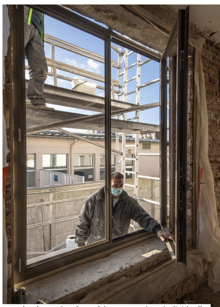
Travaux de rénovation énergétique en maison individuelle
