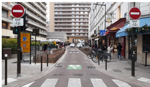
Rénovation de la rue Escudier, Boulogne-Billancourt
