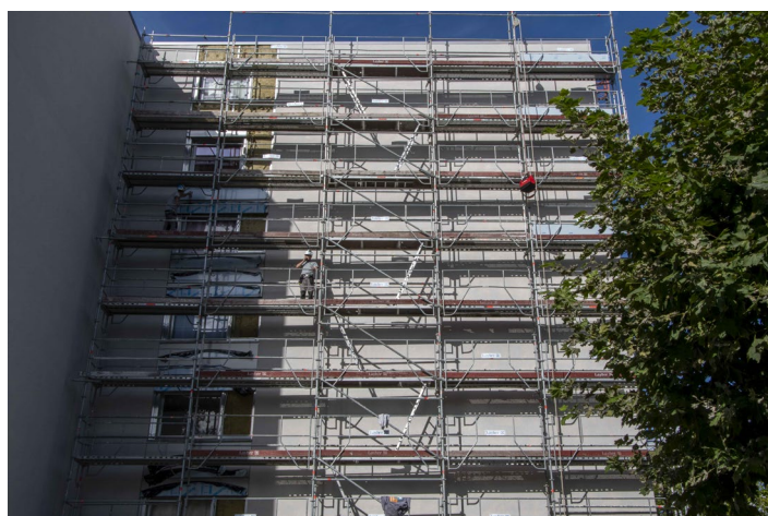
Copropriété faisant l'objet de travaux de rénovation énergétique
