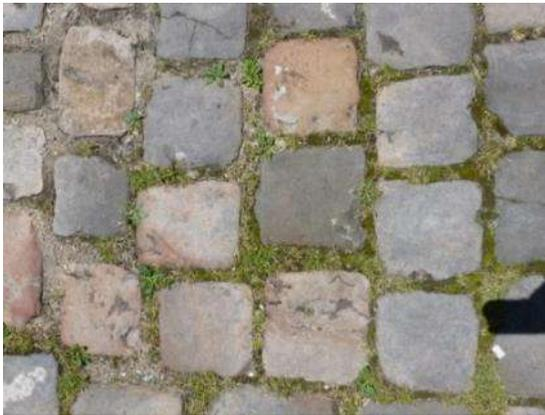
Exemple de pavage à joints de terre et sable (infiltration de 30%)
