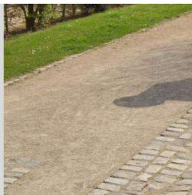
Exemple de traitement en sable stabilisé
